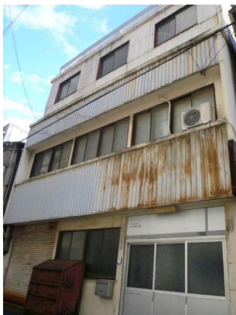
◆元印刷工場だった「本のある工場」の外観 (2023年2月撮影)
